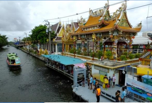
คลองภาษีเจริญ ระยะทาง 11.5 กม.
